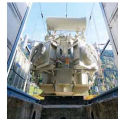
Der 51,8 Tonnen schwere Transformator wird in die Zelle eingebracht. Bild ganz oben: Streifarbeiten am Rotor.
